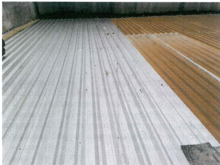
Imagem 03 – Substituição de telhas metálicas termoacústicas
